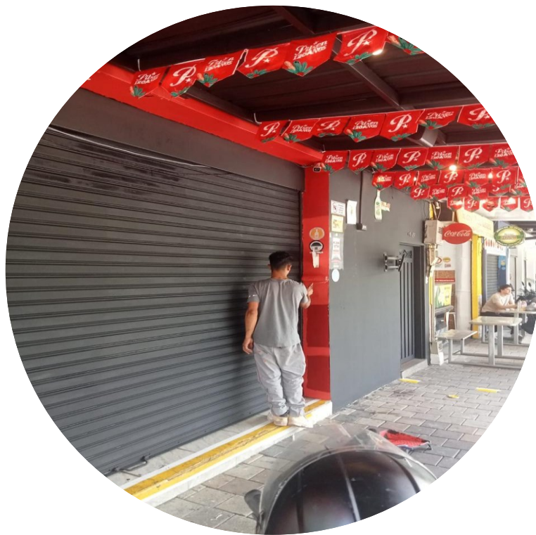
APLICACIÓN DE PINTURA EPÓXICA
