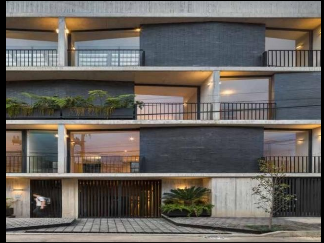
CONSTRUCCIÓN DE EDIFICIOS DE MEDIANA ENVERGADURA
