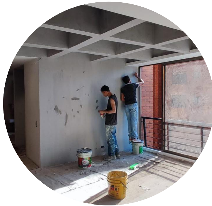
APLICACIÓN DE ACABADOS TEXTURIZADOS SOBRE REVOQUES Y ESTUCOS
