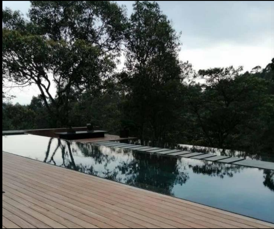
CONSTRUCCIÓN DECK Y PISCINA
